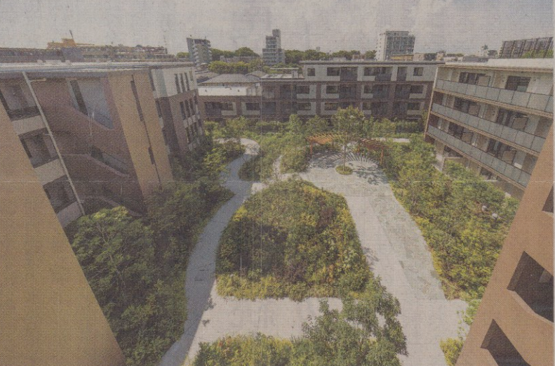
中庭に設けた植栽と建物が一体となり、美しい景観を創出(杜ノ棟)
